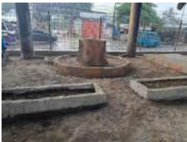
Gambar 1 : Pembuatan Paving Block Untuk Media Tanam
